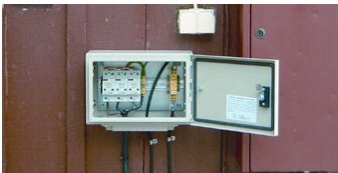
Exempel på inledningsskydd för el och tele.
